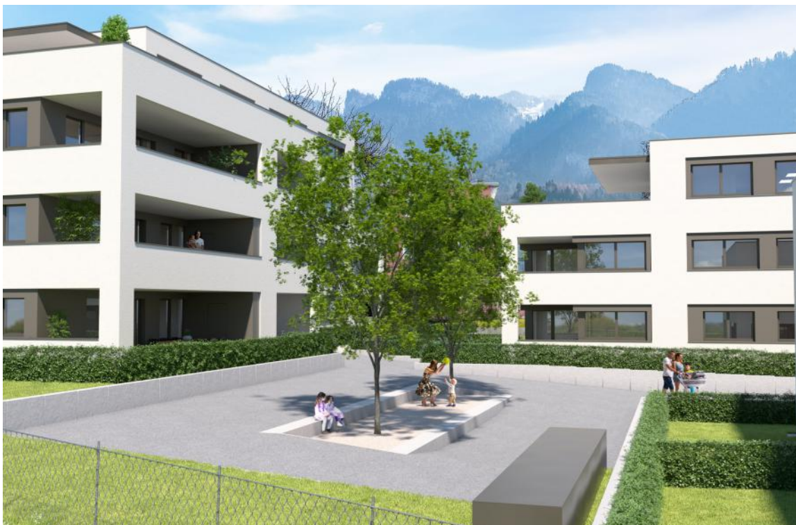
Ansicht Westen: Innenhof
